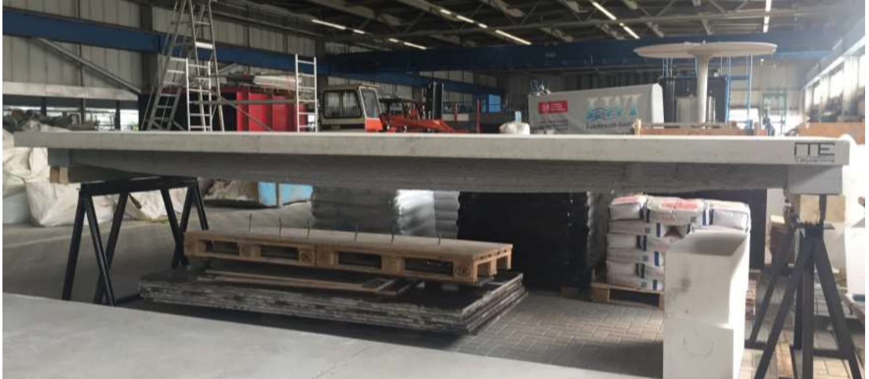
Hybrid gedruckte Rippendecke TU Braunschweig 2018 (© ITE)
