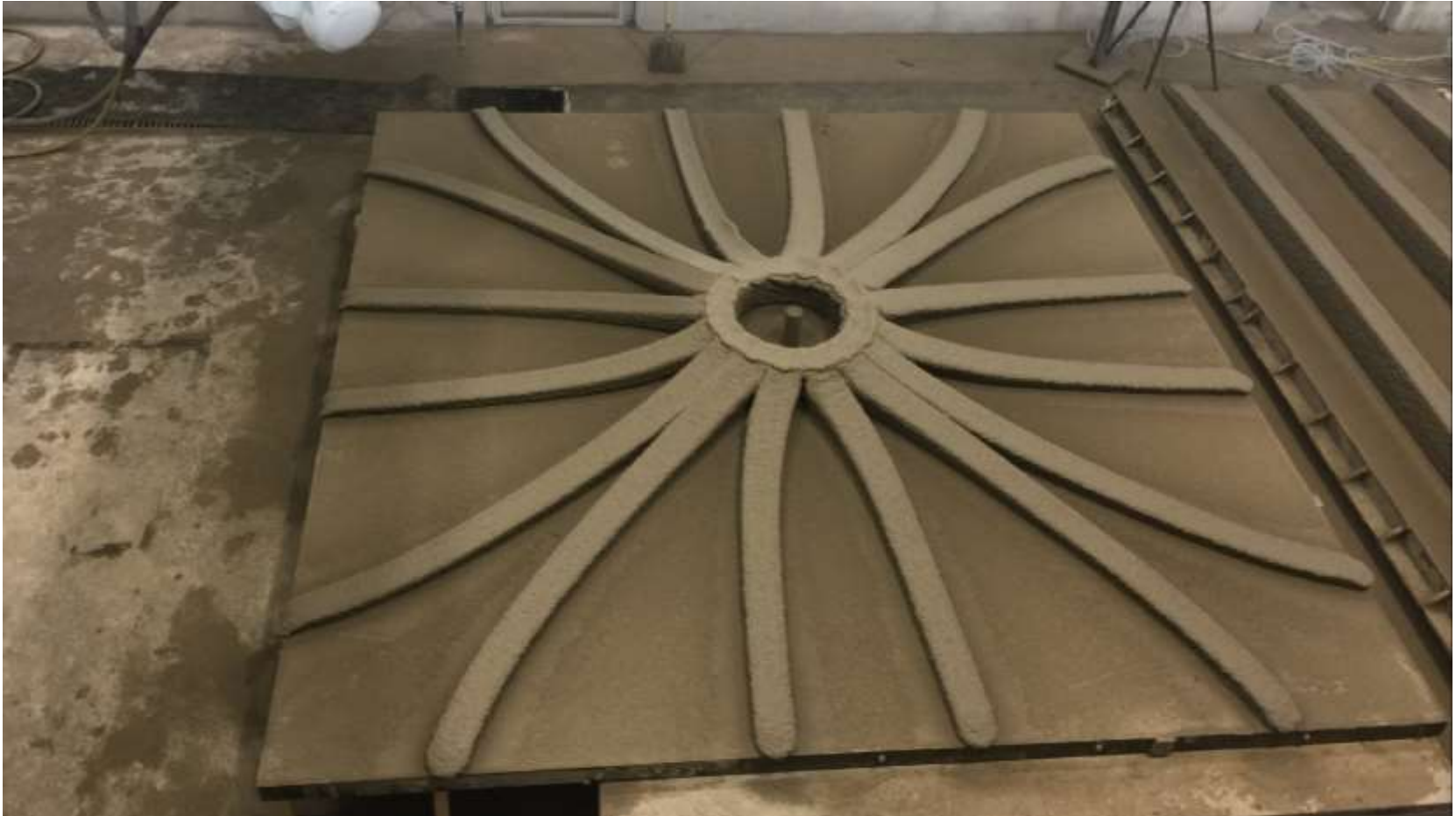
Hybrid gedruckte Freiform-Rippendecke TU Braunschweig 2018 (© ITE)
